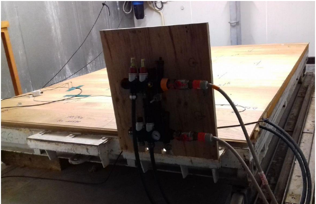
Maquette d'essai du Système Parquet sur sol chauffant rafraichissant 3mx2m avec systèmes de capteurs de mesure température et humidité
