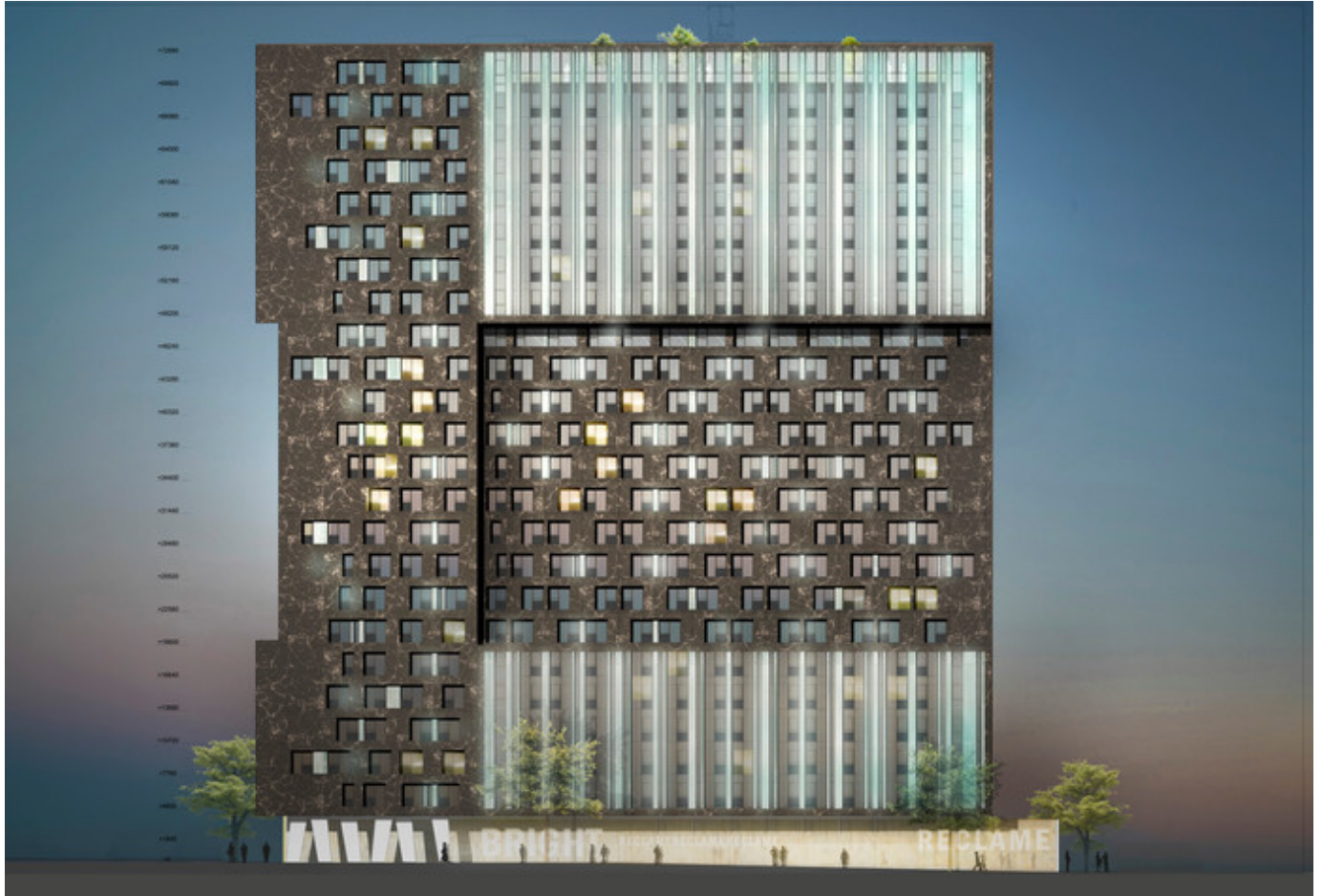
▲ De oostgevel van Bright, langs de André van der Louwbrug. © Tangram Architecten
