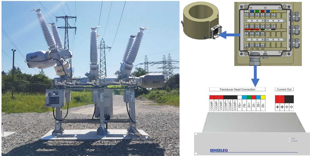
Abbildung 13: Fluxgate Stromwandler an der Schaltanlage HYpact von GE
