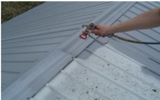
Figura 12 Recubrimiento de cumbrera
