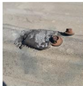
Figura 2 Tornillos de fijación oxidados y sueltos
