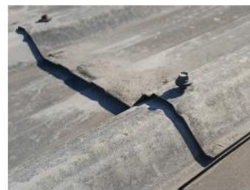
Figura 2 Tornillos de fijación oxidados y sueltos
