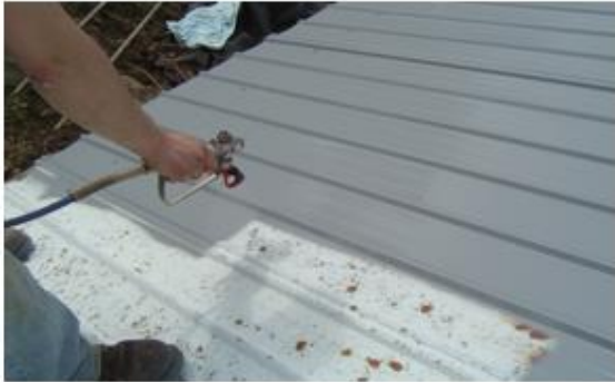
Figura 10 Recubrimiento de páneles
