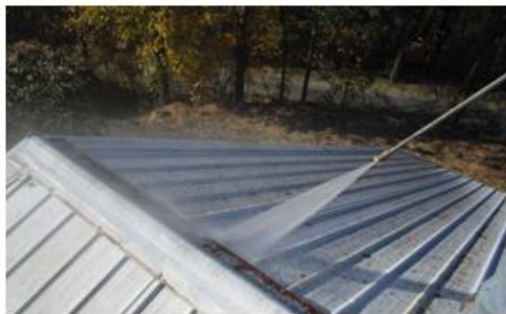
Figure 8 Lavado de cumbrera a presión
