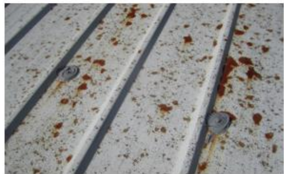
Figura 7 Sellar cabezas de tornillos que lo requieran
