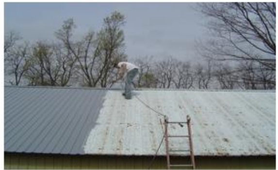
Figura 9 Lavado con agua a presión
