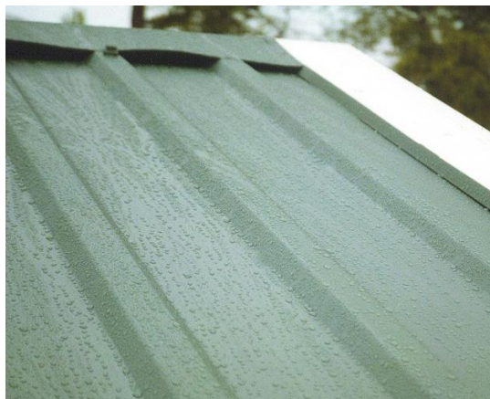
Figura 3 Techo metálico con recubrimiento de silicón
