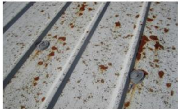
Figura 7 Sellar cabezas de tornillos que lo requieran
