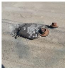
Imagen 3: Sujetadores corroídos y flojos
